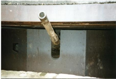
Exemple de casemate équipée du canon de 50 mm
