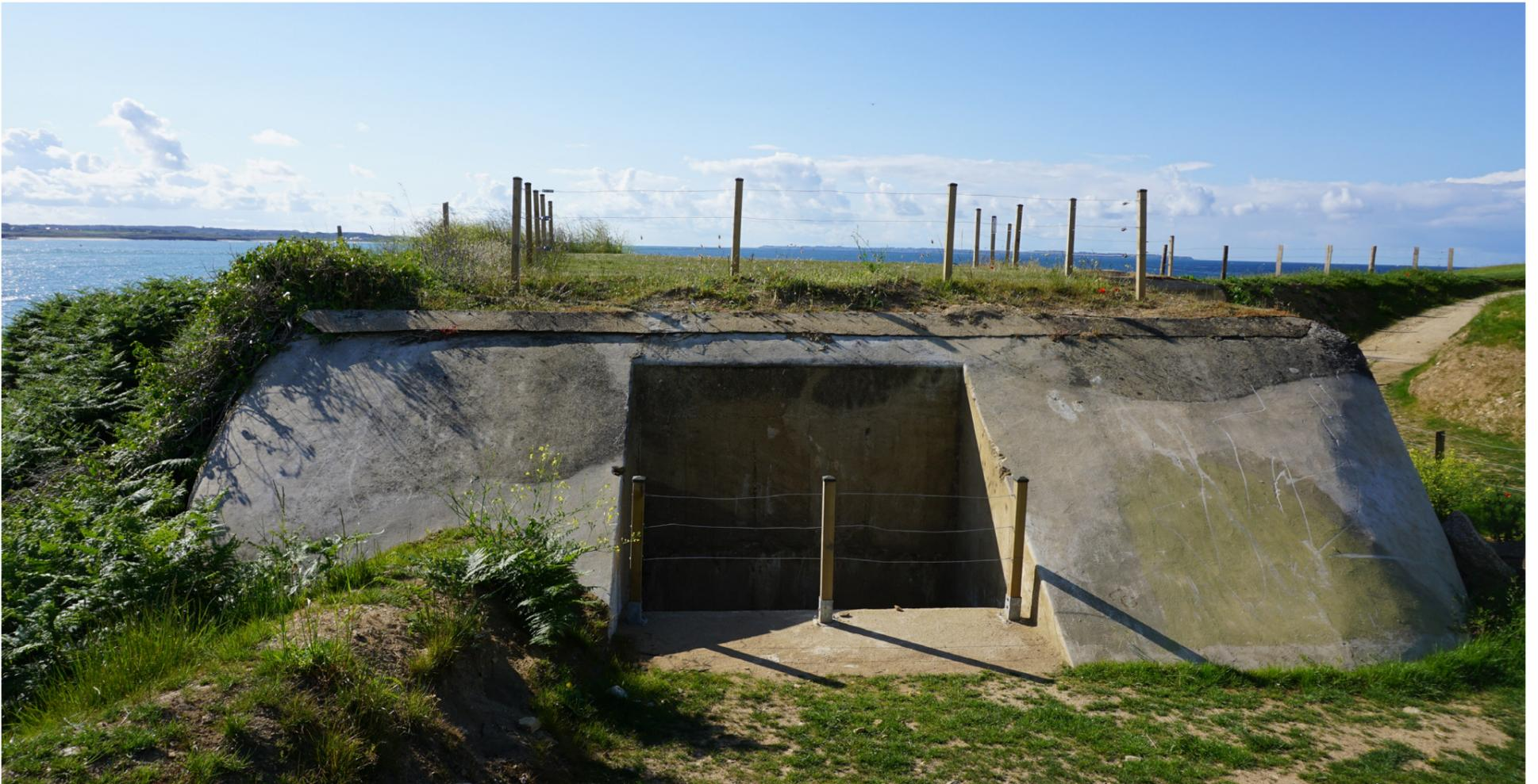
La goulotte intégrée dans le mur à l'arrière gauche du canon était prévue pour éjecter vers l'extérieur les douilles de 75 mm tirées.
