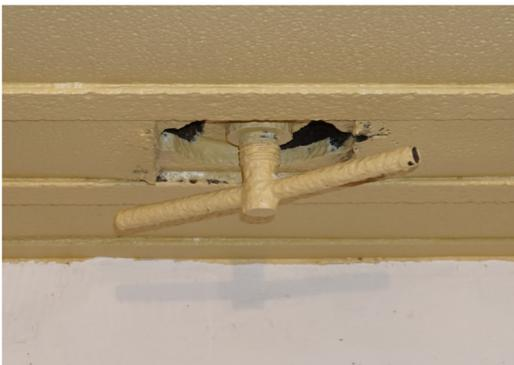
*Dans le plafond de l'abri fut placée une trappe technique pour positionner un périscopie de bunker. (N 3)*
