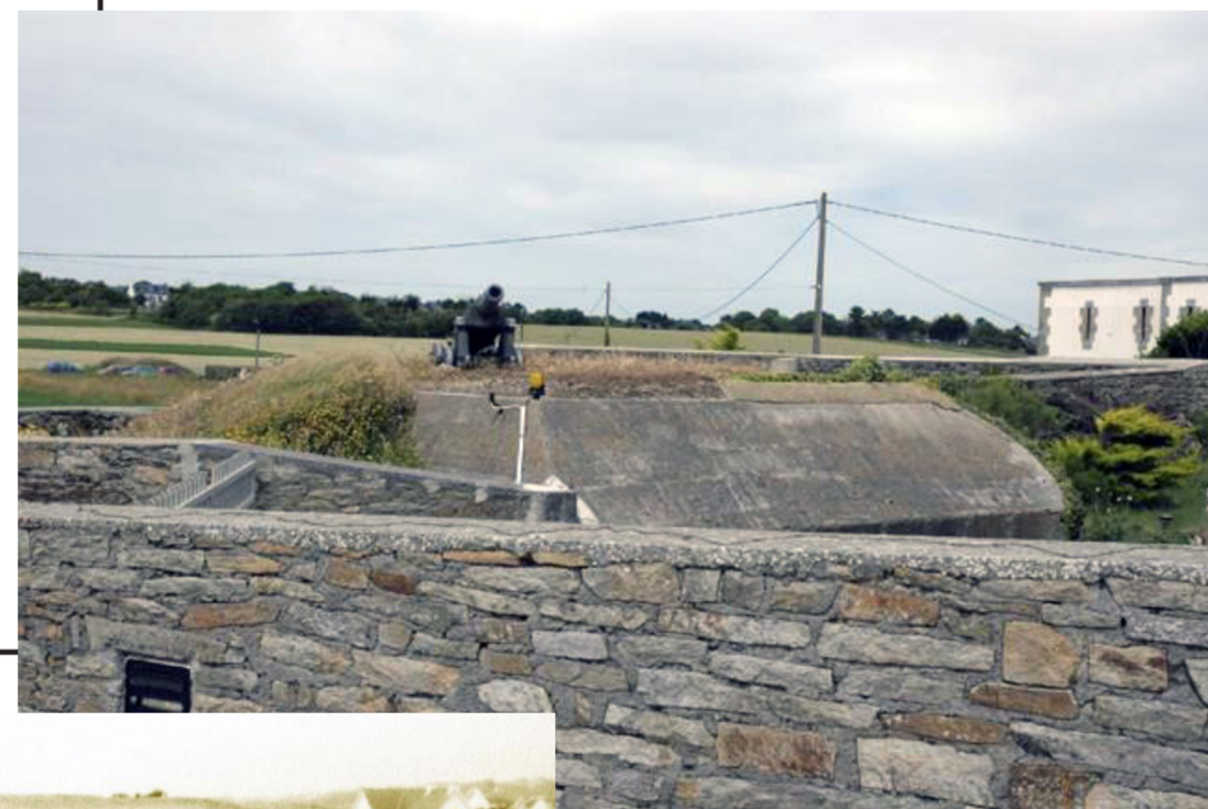
Casemate pour pièce de 50 mm (position n°5)
