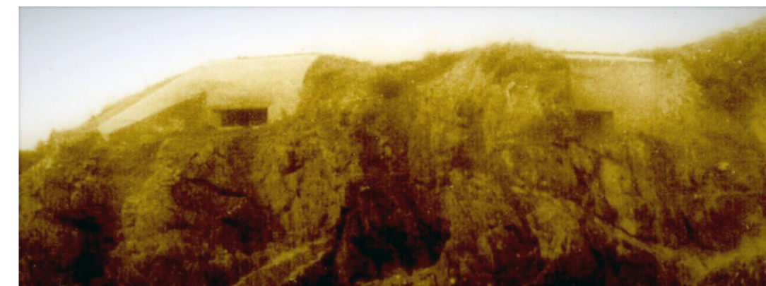
Casemates au dessus du port en 1945
