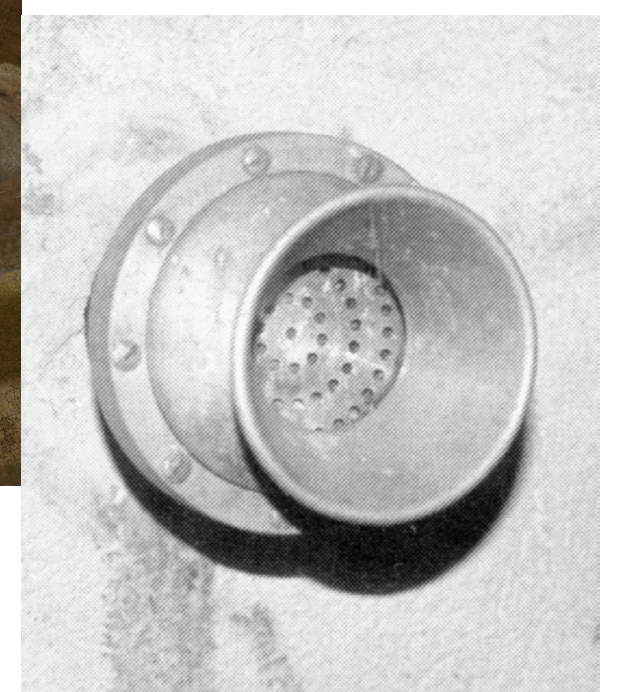
Cornet de communication acoustique relié à la casemate.
